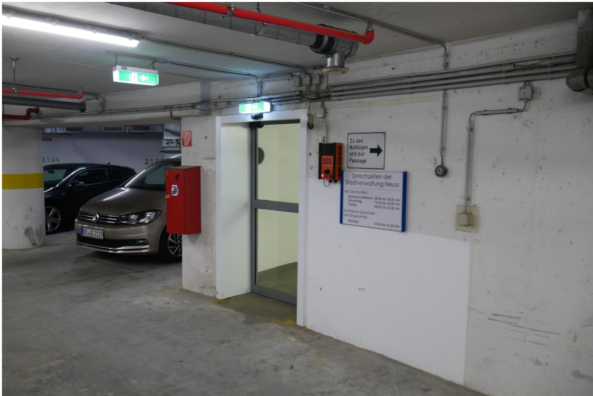
Abbildung 16: Tiefgarage Stellplatz auf Parkdeck 2, links und rechts vom Aufgang
